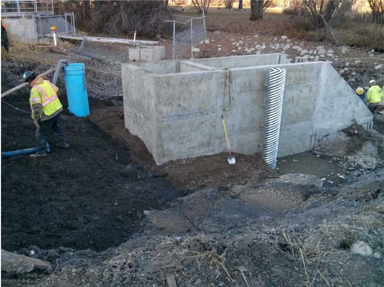
8. Lake Creek structure after pour
